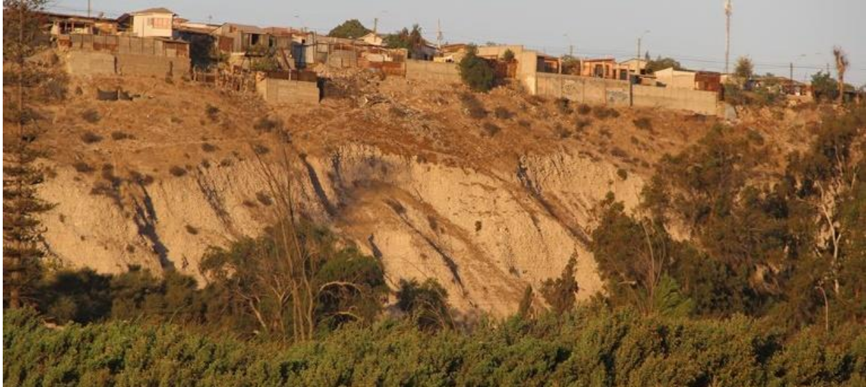
Figura 11. Ladera norte erosionada
