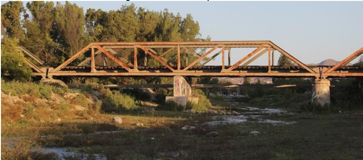
Figura 10. Lecho río en parte central
