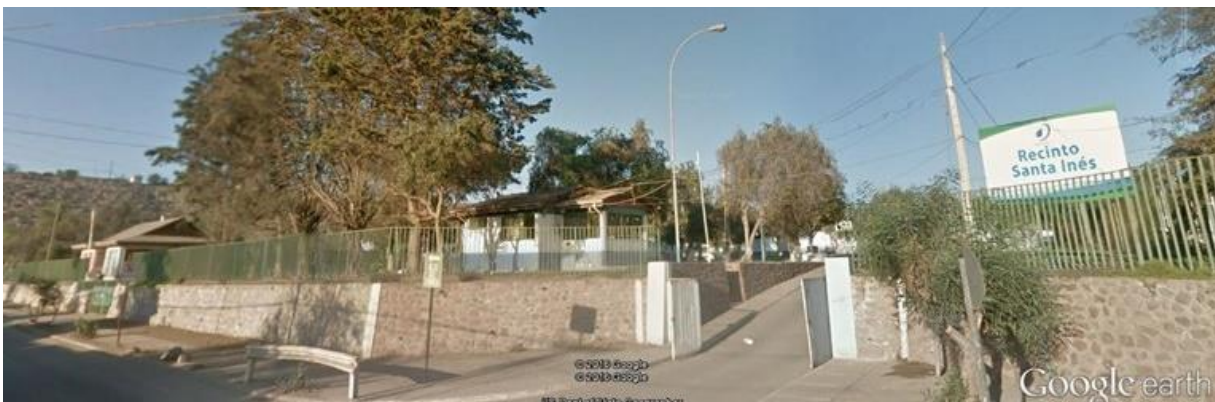
Figura 14 Vista acceso a recinto Aguas Chañar – Ex SENDOS.
