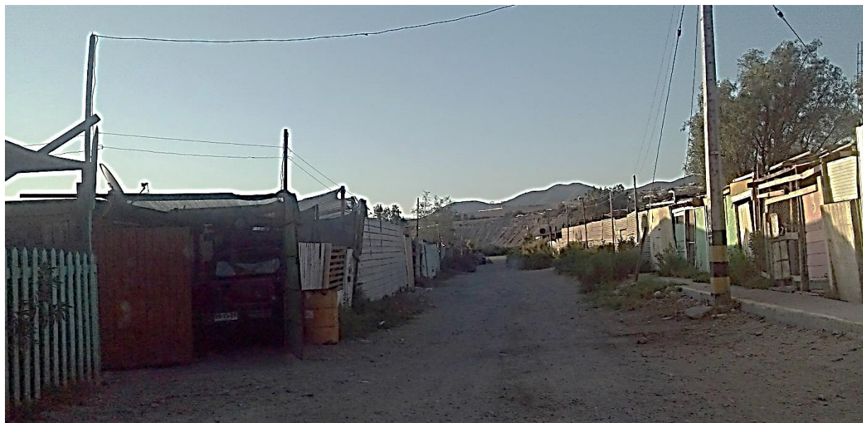
Figura 7. Viviendas ubicadas en área ZR1
