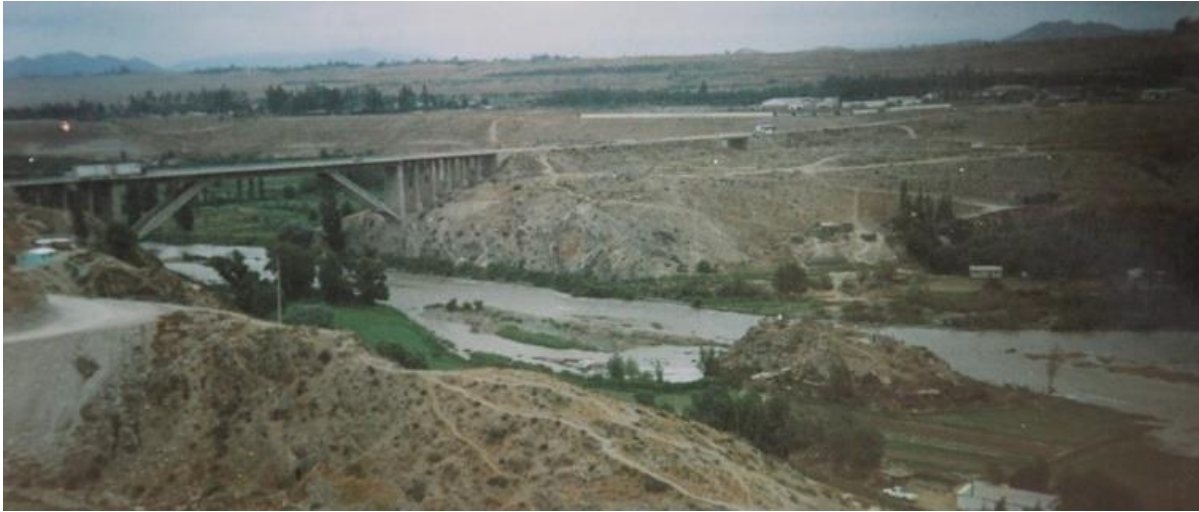
Figura 15. Vista río Huasco durante crecida del año 1997
