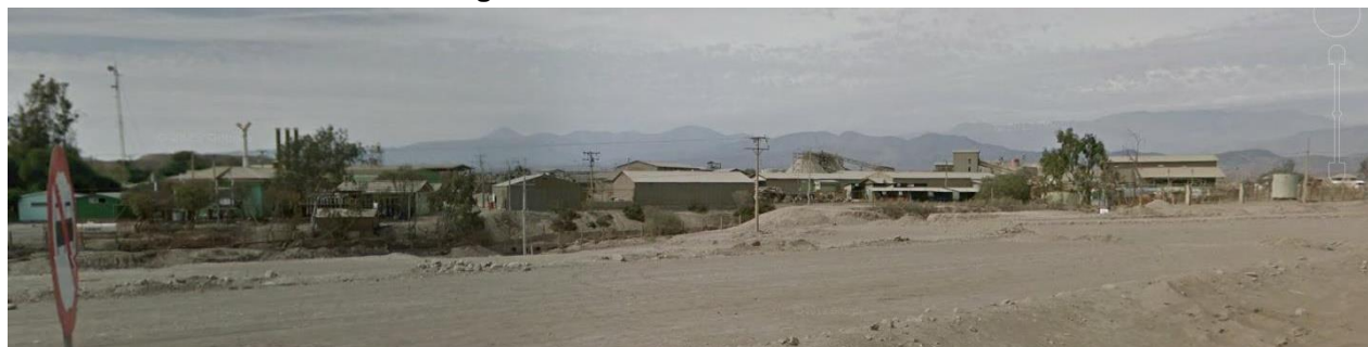
Figura 22. Instalaciones de ENAMI.
